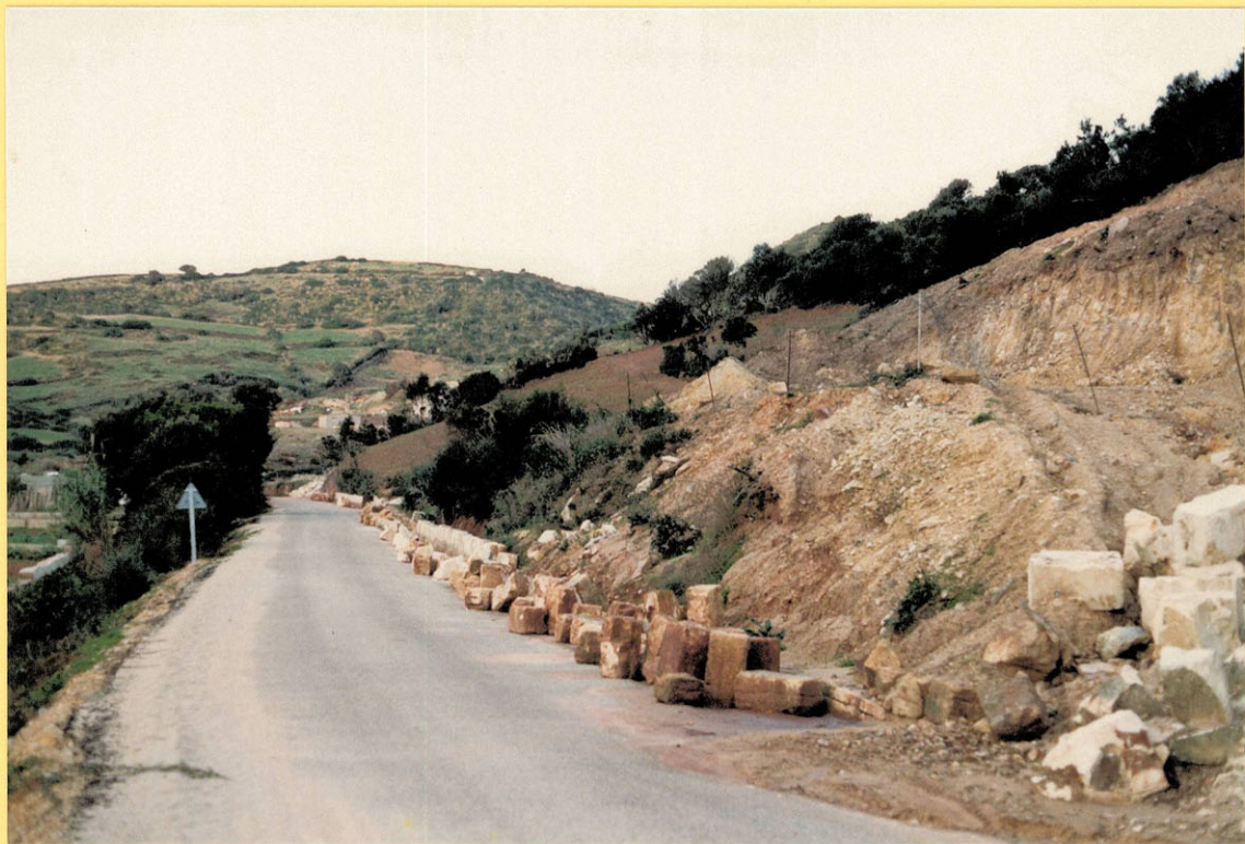
Foto 9. Colocación de muros de contención en materiales de las Zonas II_1 y I_3 , al N. de Ferrerías.
