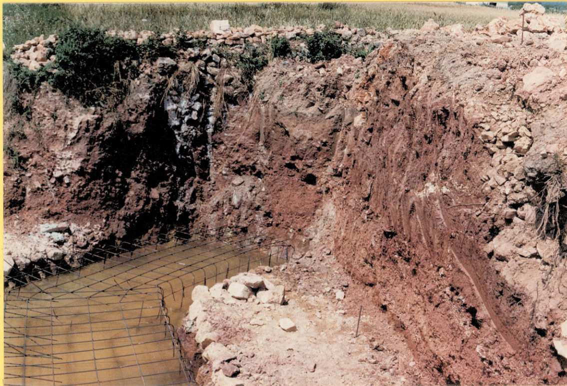
Foto 23. Zanja realizada en material aluvial, cercano a Mercadal. Camino de Kane.
