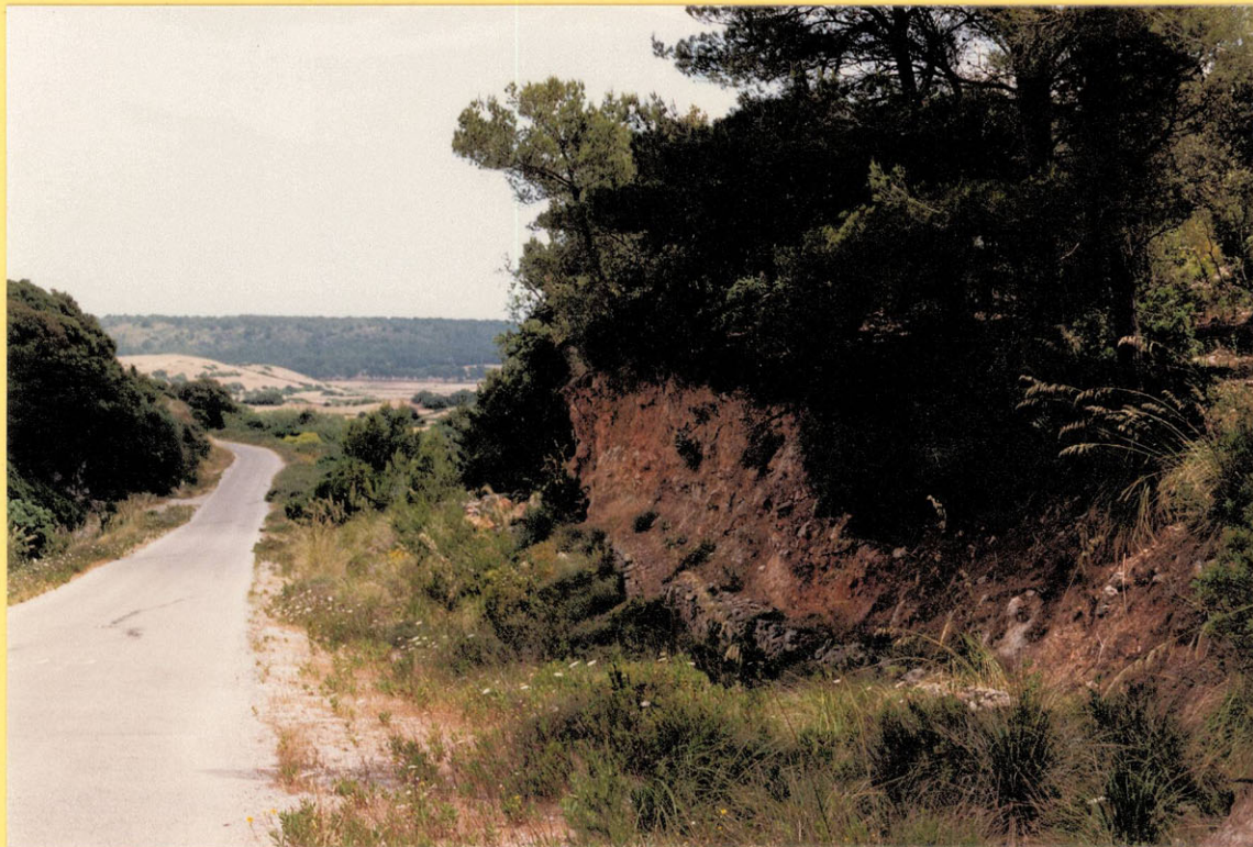
Foto 12. Aspecto de los depósitos superficiales, sobre las dolomías de la Zona II 4 . Carretera de acceso a Sa Roca.
