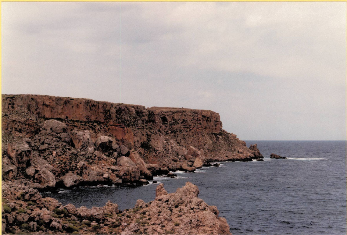
Foto 27. Caída de bloques, en el acantilado del Cabo de Cavallería.
